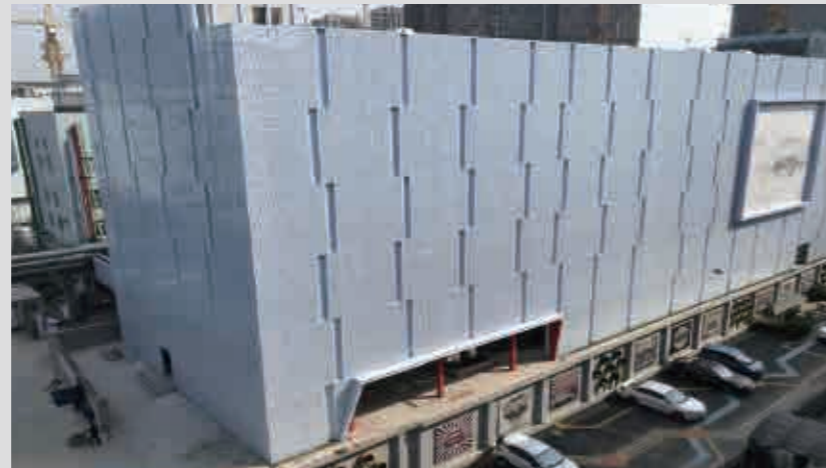
中美华东大分子药物研发专业实验室技术改造项目完工
