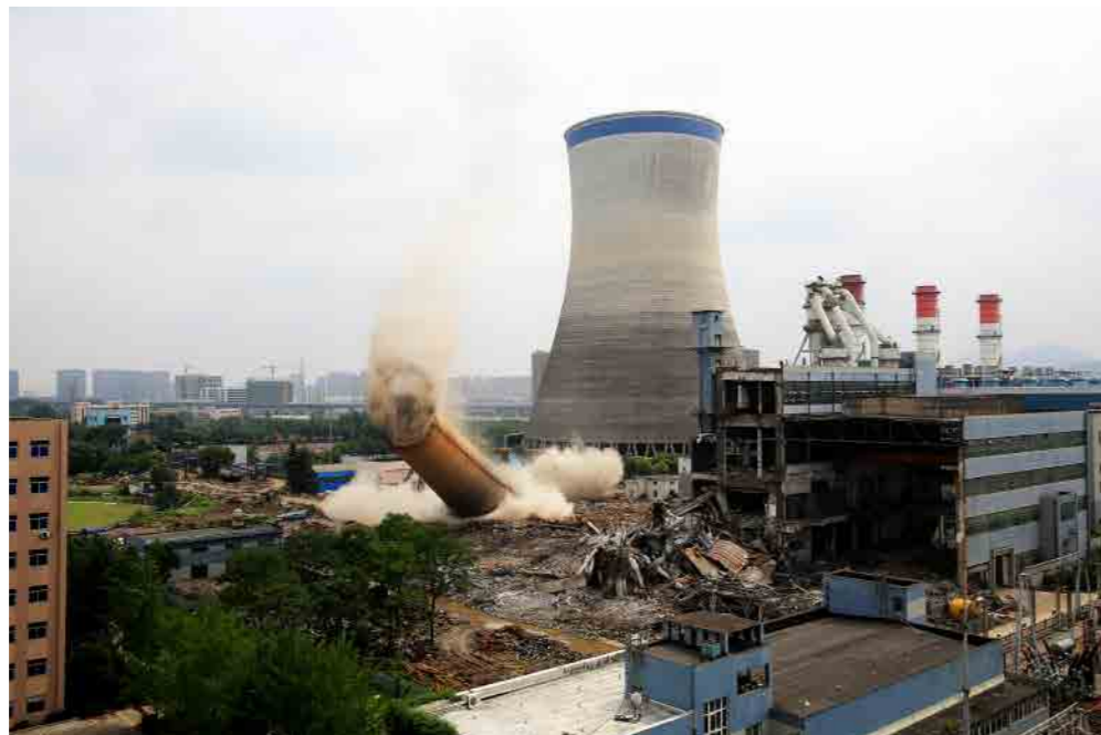
华电半山冷却塔、煤机烟囱拆除
