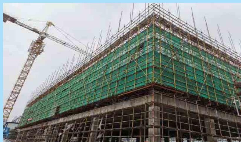
中美华东制剂大楼施工中
