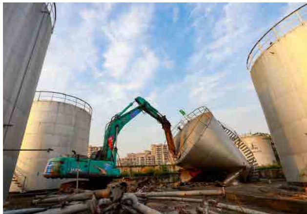
小河油库拆除
