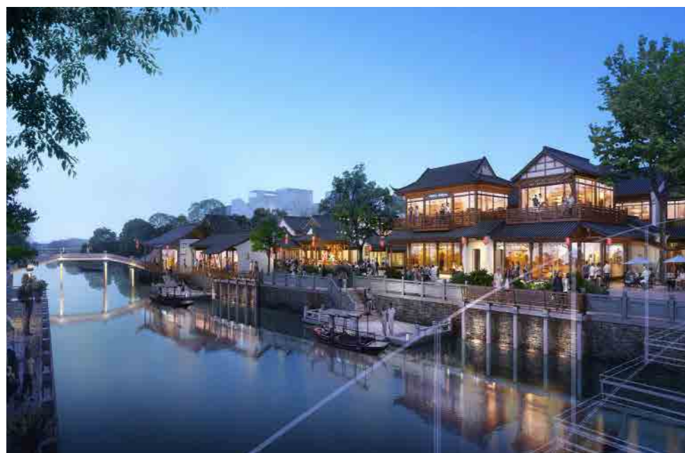
祥符桥传统风貌街区开工
