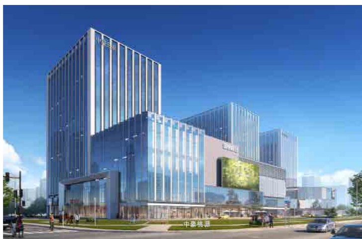
中豪企业总部中心开工
